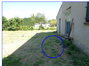
Mise en place d'un regard contrôle
