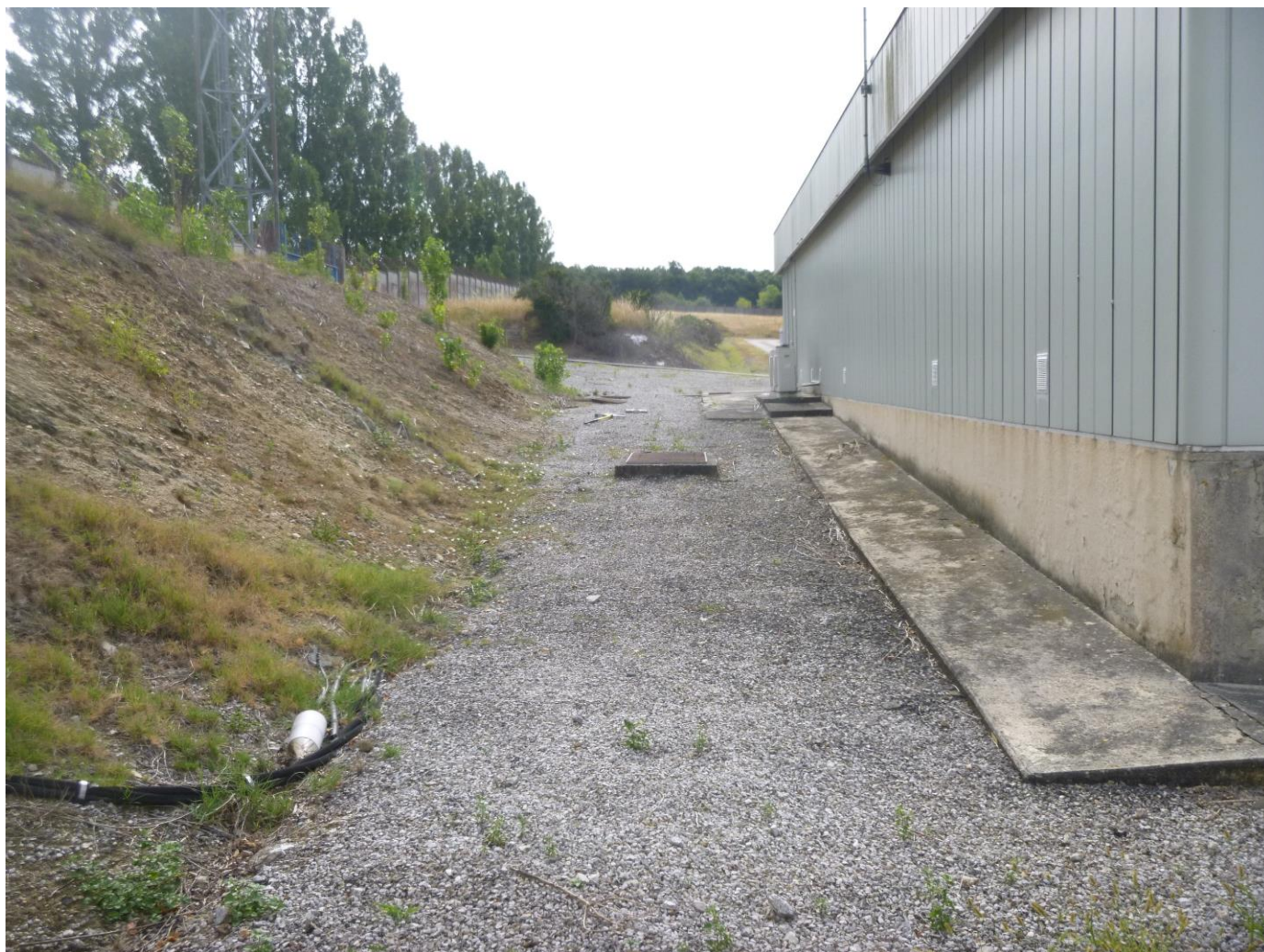
Figure 9 : Vue d'ensemble de la zone d'infiltration (depuis l'aval)
