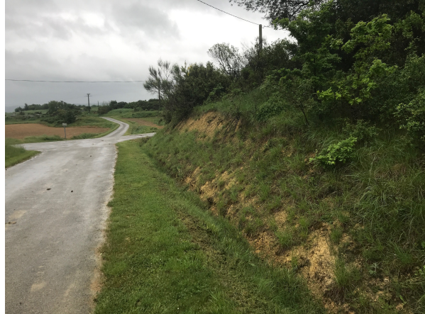
Vues sur les talus de terrassement réalisés dans la butte
