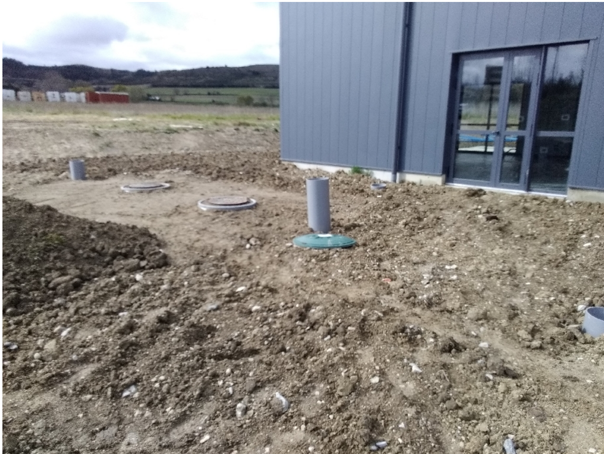
Photo station dans environnement
