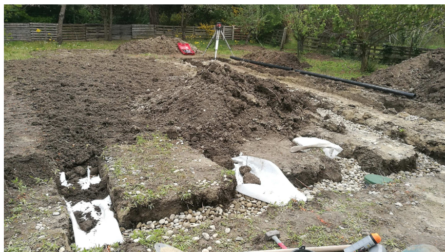
Tranchée d'épandage à faible profondeur 50ml
