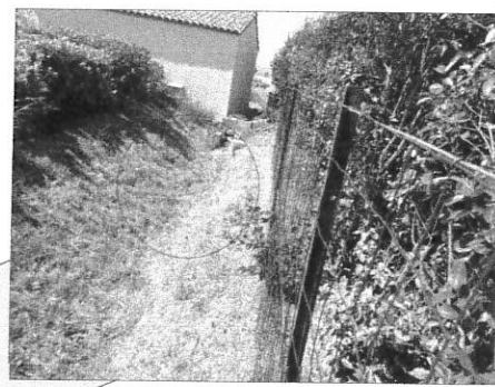
Rejet au fossé avec Clapet anti retour
