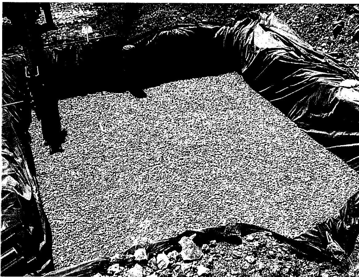
Graviers de granulométrie 15 – 25 mm
