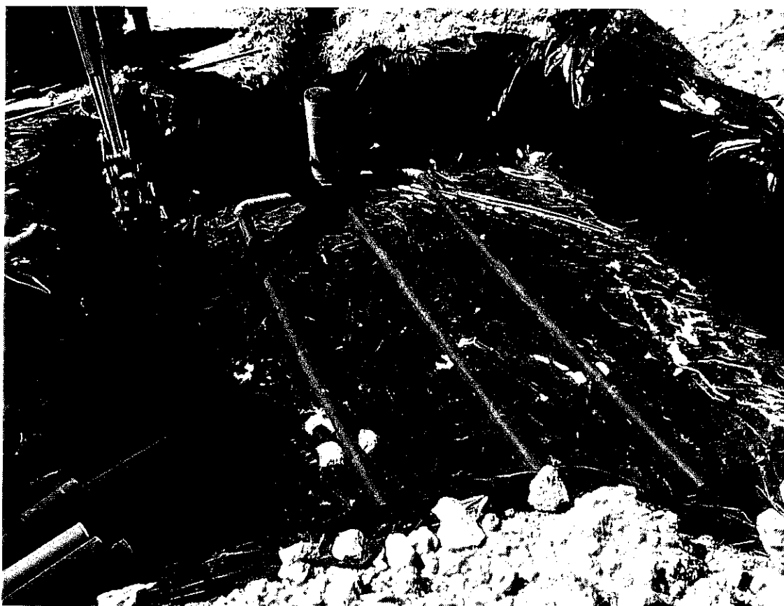
Drains de collecte sous le film imperméable
