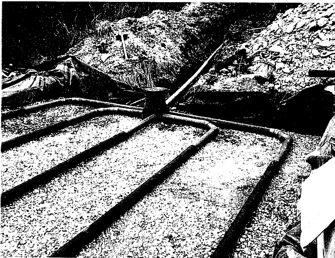
Tuyaux de répartition sur une couche de graviers de granulométrie 20 – 40 mm
